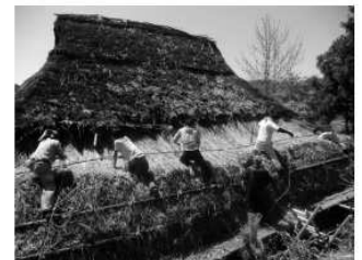
写真-3 屋根葺き替え
