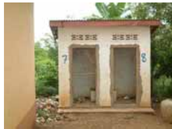
校舎横のトイレ 通常トイレはどこでも設置されるが、使用されていないケースが多い。下水処理の仕組みとセットで整備されないため、汚物がすぐたまる。
