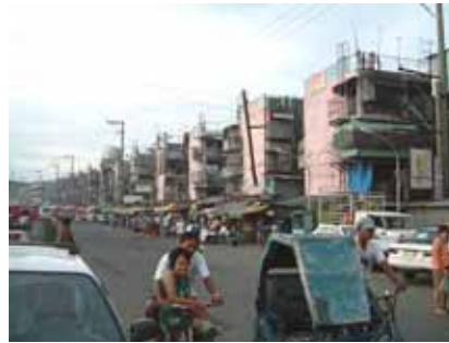
調査対象住宅全景 アジア最大のスラムと言われたスモークマウンテンのすぐ隣に1980年代に建設される。20棟近くが棟を連ねる。
