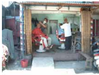
1階にある床屋 集合住宅の1階部分を改造して床屋として利用している。建具で閉じることが可能であるが、通常は半屋外空間の中で髪を切る。
