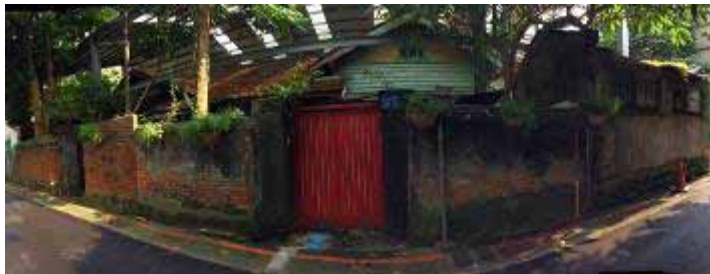
腐らないように鉄骨で屋根までかけて保存されている。
