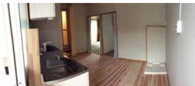
一般的な内装。県産材を、キッチンの床に張り、和室の腰壁も県産材。
