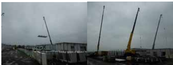
急ピッチでの建設現場
