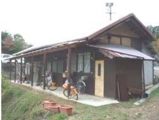
写真-2 広瀬後援会による空き家活用住宅
