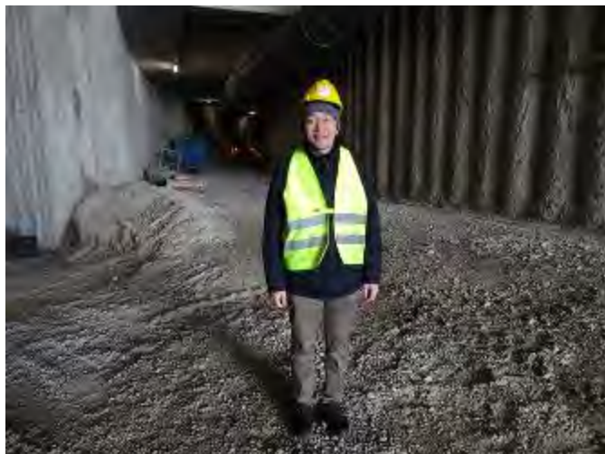
写真 4 Luise-Kisselbach 広場 (ミュンヘン) の地下トンネル工事現場にて
