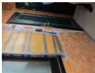
マンモスマンションで雑壁が×状に破壊され、扉が開かなくなった例。高架水槽も振られて配管などが破壊されている。しかし、柱・梁などの躯体は問題なかった。
