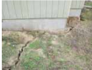
大槻町八坦では、がけが崩れ、全壊の建物が続出した。地割れで50cmほどの段差がついている。
