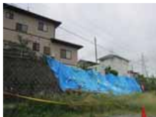
大槻町八坦では、がけが崩れ、全壊の建物が続出した。地割れで50cmほどの段差がついている。
