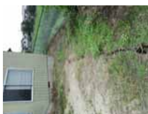
大槻町八坦では、がけが崩れ、全壊の建物が続出した。地割れで50cmほどの段差がついている。
