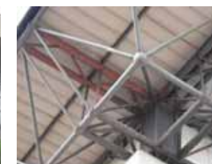
屋根トラスのボルトが破断し落下。
