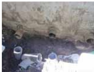
市営住宅で土が液状化で沈んだため、下水管が殆ど折れてしまい、土に接している土間が沈み込んだため1階の腰壁などが破壊されている例。本体に影響があるわけではないので、被害の判定は低い。
