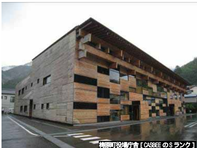
梶原町役場庁舎【CASBEEのSランク】
