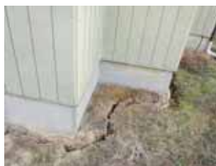
貯水池脇でがけに向かって沈み込み、基礎の下の土が絡げ取られている借家。室内では床に30°の傾斜がついている。
