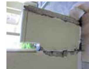
市営住宅で土が液状化で沈んだため、下水管が殆ど折れてしまい、土に接している土間が沈み込んだため1階の腰壁などが破壊されている例。本体に影響があるわけではないので、被害の判定は低い。
