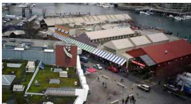
写真：グランビル・アイランド 俯瞰写真
