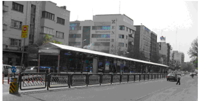
(広幅員幹線道路の中央に設置されたバス駅)
