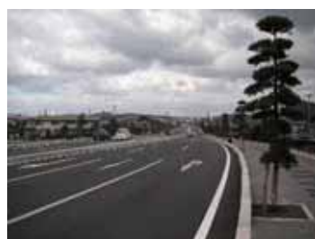
開通したばかりの国道262号:三角州を縦貫する幹線道路
